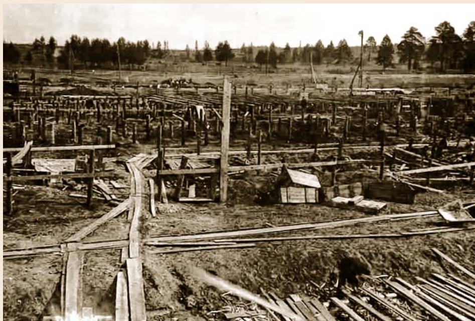
Площадка строительства ЗМК-2. Июнь 1942 г.
