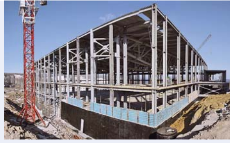
Каркас здания спортивного блока на о. Русском. Объем 1560 тонн. 2010 г. A framework of the Sports block's on Russian Island. Capacity of 1560 tons. 2010.
