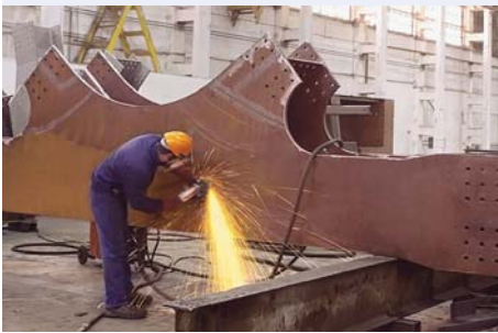
Контрольная сборка металлоконструкций для Центрального олимпийского стадиона в Сочи. Фото 2011 г. Control assembly of the constructions for a Central stadium in Sochi. Photo of 2011.
