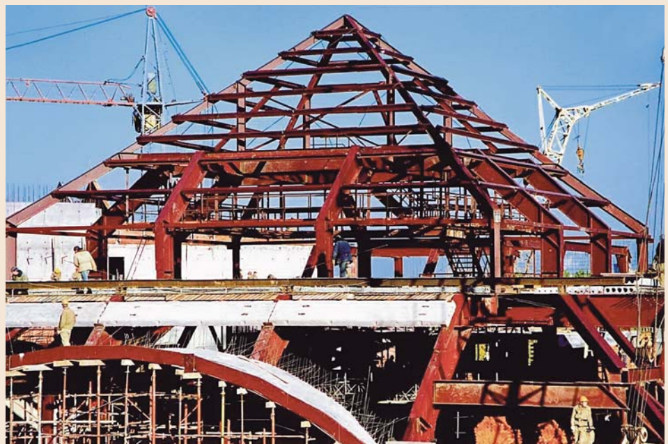
Строительство бассейна в Москве. Фото 2006 г. Construction of The Swimming Pool in Moscow. Photo of 2006.
