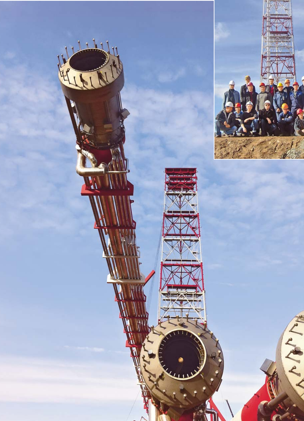
Объекты для нефтегазового комплекса. Генерация. Факельные стволы. Фото 2010 г.
