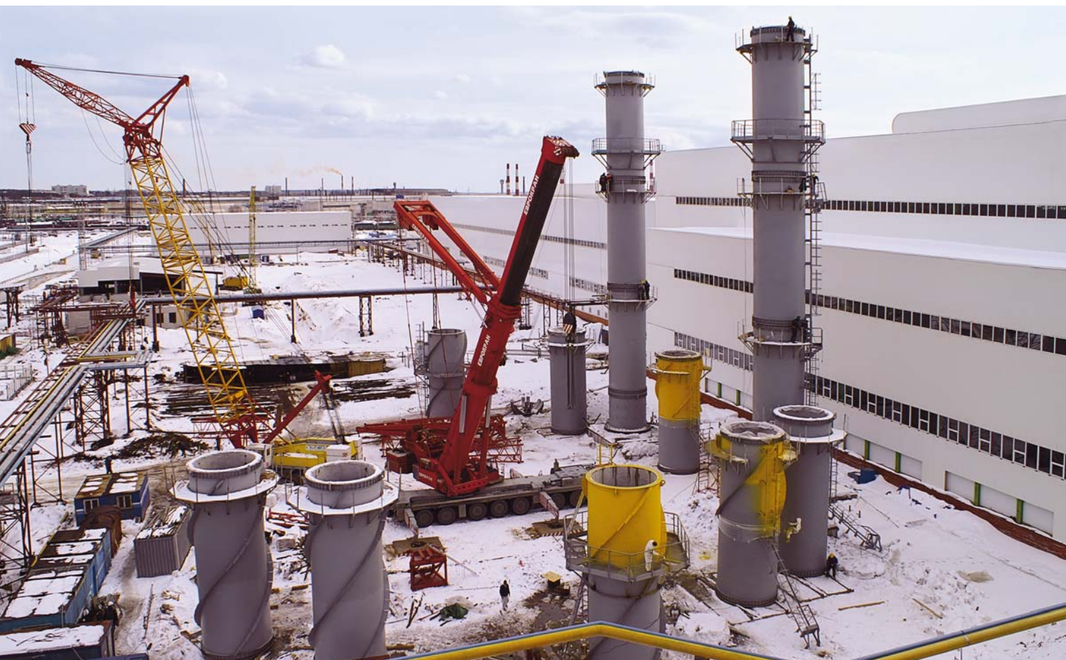
Стан «5000». Укрупнительная сборка. г. Выкса. Фото 2010 г.
