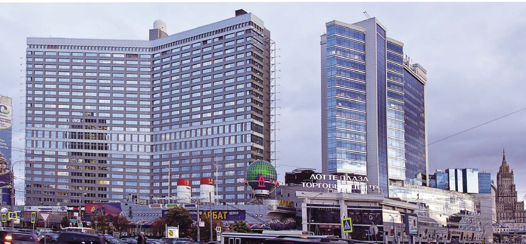
Многофункциональный гостинично-деловой комплекс по ул. Новый Арбат в Москве. Колонны до отметки 8.400. Несущие конструкции атриума. Объем 650 тонн. 2008–2009 гг. Фото 2011 г.
