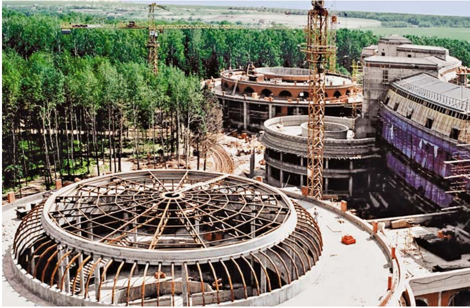
Строительство санатория «Дружба». 2006 г.
