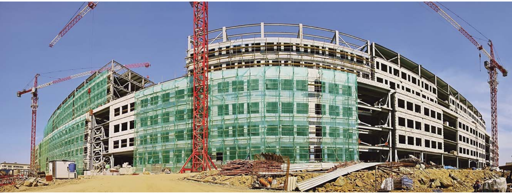
Каркас здания гостиничного комплекса ДВФУ на о. Русском. Объем 3800 тонн. 2009 г. A framework of the hotel complex's building of Far East Federal University on Russian Island. Capacity of 3800 tons. 2009.
