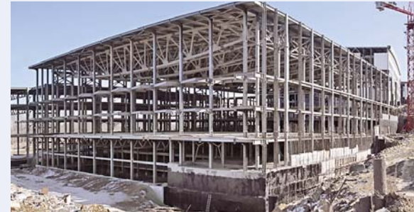
Каркас здания спортивного блока на о. Русском. Объем 1560 тонн. 2010 г. A framework of the Sports block's on Russian Island. Capacity of 1560 tons. 2010.
