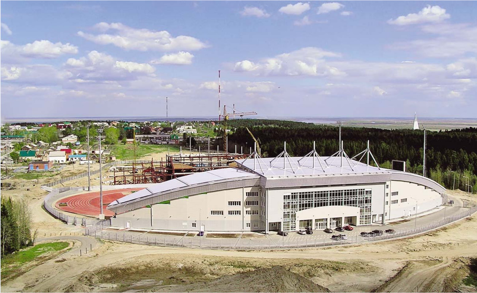
Строительство стадиона в Ханты-Мансийске. 2006 г. Каркас, покрытие. Объем 1300 тонн. 2004 г. Фото 2006 г.
